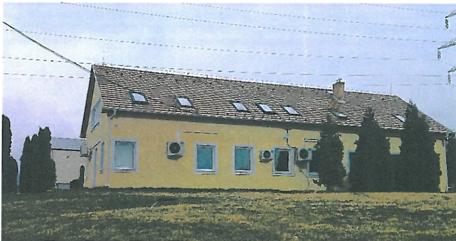
Fotó: felújított homlokzat
